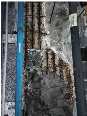
jàssera a, escantell del formigó i oxidació de les armadures
