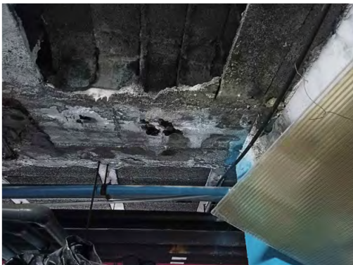
disgregació d'una sèrie de revoltons de formigó propers a la jàssera a, donat l'ambient corrosiu del soterrani,
