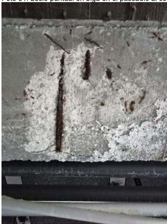
Foto 31. Lesió puntual en biga en el passadís al costat del vas de compensació.
