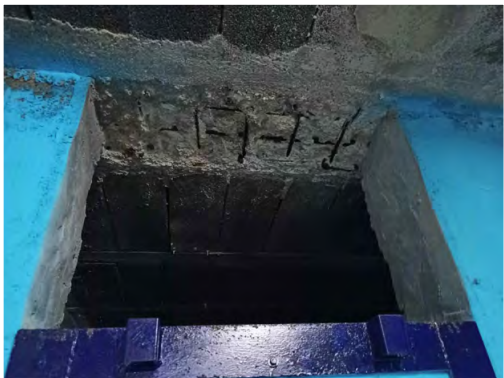
escantell del formigó, desprotecció de les armadures i oxidació de les mafeixes, en les obertures del dipòsit (vas de compensació de la piscina)
