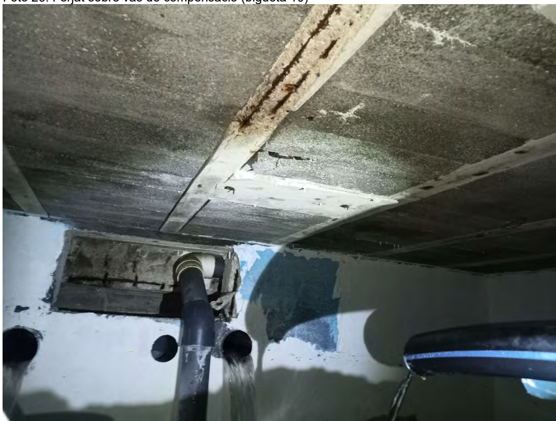
Foto 26. Forjat sobre vas de compensació (bigueta 10)
