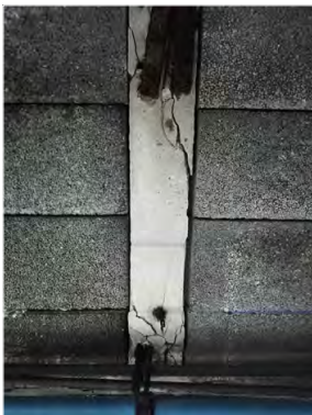
biguetes 7 fissura del formigó i visible oxidació dels elements metàl·lics de subjecció de les instal·lacions
