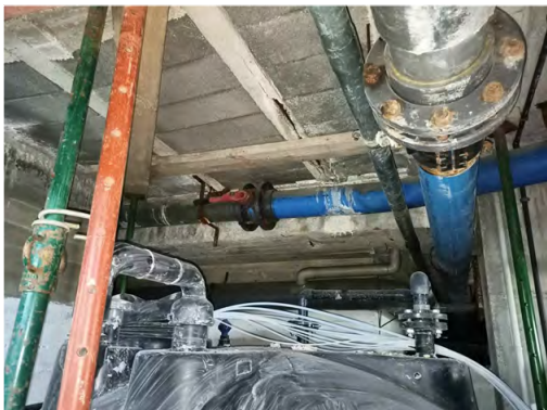
fissura del formigó i corrosió de les armadures de les biguetes 1 i 2
